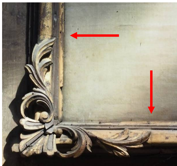
Dorure sur encadrement du transept sud Joints de part et d'autre des parties sculptées
